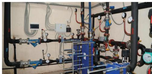
**7.2. Тепловые пункты** являются одним из элементов тепловой сети, выступают в качестве связующего звена между магистральной сетью и распределительными тепловыми сетями, которые идут непосредственно к потребителям тепловой энергии (в больничные корпуса). В стационаре тепловые пункты могут быть расположены в
