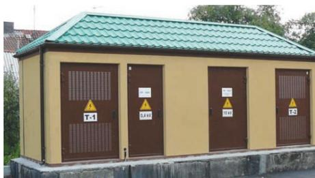
жение при соответствующем снижении силы тока, в то время как понижающая подстанция уменьшает выходное напряжение при пропорциональном увеличении силы тока.
